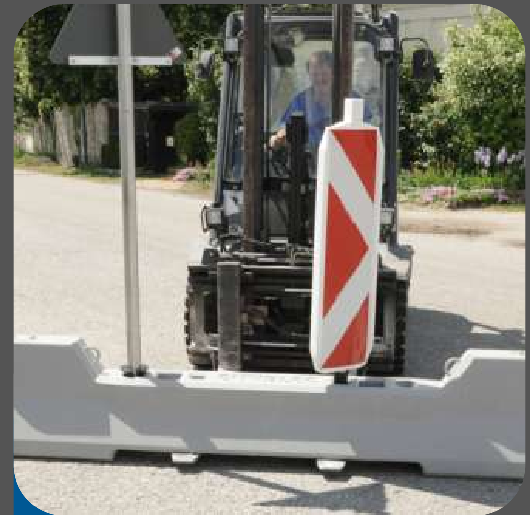
PRZY PRACACH DROGOWYCH
